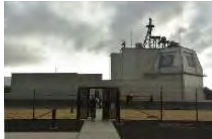
米ハワイ州カウアイ島にあるイージス・アショアの試験施設。建物右上部の壁にレーダーの平板アンテナが取り付けられ、上部に管制や通信用のアンテナがある＝2018年1月10日午前8時28分、秋山信一撮影
