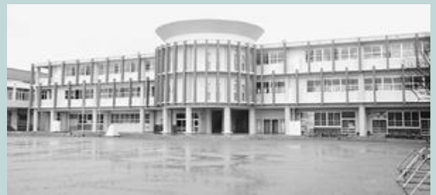
(写真) 名護市内の小中学校で、クーラーの設置やトイレの改修、耐震化が進みました
