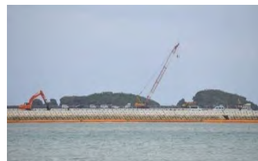
工事が進む名護市辺野古
