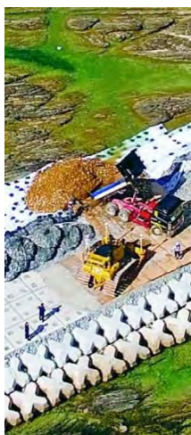
(写真) 土砂の投入作業が強行された「N
