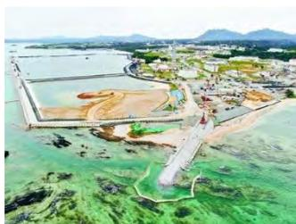
(写真) 埋め立て工事が進む名護市辺野古沿岸部。写真右側の大浦湾側に軟弱地盤が存在しており、
