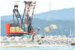
被覆ブロックの設置が進む「N4」護
