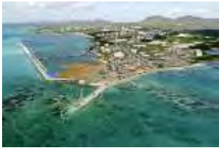
埋め立て工事が進む沖縄県名護市辺野古沿岸部＝2月23日（小型無人機から）
