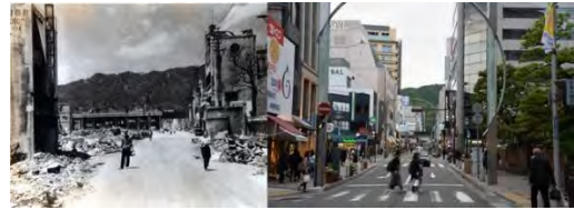
【左】写真家・中山岩太が撮った空襲後の神戸の街【右】ほぼ同じ位置から撮影したトアロードの現在。鉄道の高架や山の形が位置特定のきっかけになった＝神戸市中央区
