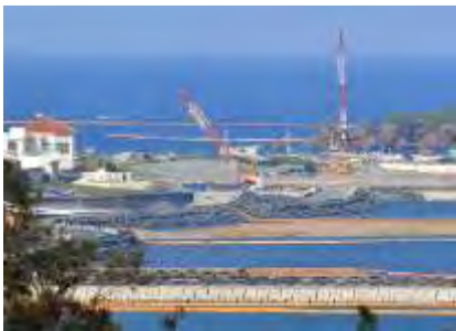
移設工事が進む辺野古沿岸部
