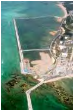
埋め立て工事が進む辺野古の米軍キャンプ
