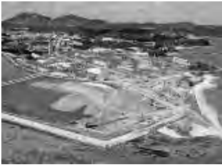
(写真) 新基地建設に伴う埋め立て
