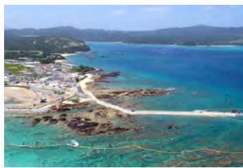
大浦湾側に向かって工事が進む
