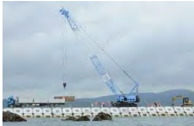
整備作業が続く、沖縄県名護
