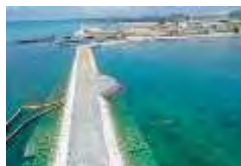
沖縄防衛局が新たに埋め立て用土砂の陸揚げ場所として使用を計画しているK8護岸（手前）。当初県に報告していた護岸の構造が許可なく変更されている＝6日、名護市辺野古（小型無人機で撮影）
