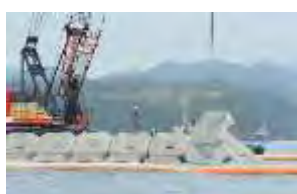
被覆ブロックの設置が進められる
