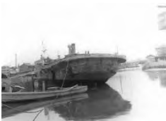
強力造船所で改装工事中の第五福竜丸＝
