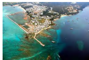
埋め立て工事が進む辺野古沖。右側
