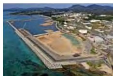
工事が進む沖縄県名護市の海岸（2 月）
