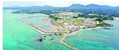
（写真）土砂投入が強行さ
