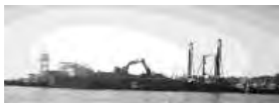
(写真) K9護岸での作業現場
