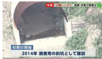
上空から見るとアーチ状の構造物が見えた
